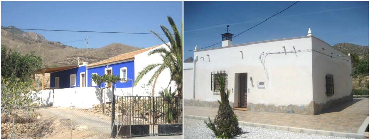
Figura 5. Arquitectura tradicional con cubierta a dos aguas en Torre de Nicolás Pérez (izqda.) y con cubierta plana en Los Fuentes de Galifa (dcha.)
