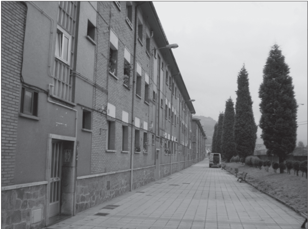
2. COLOMINAS EN LA CUENCA DEL CAUDAL (SANTA MARINA, MIERES)
