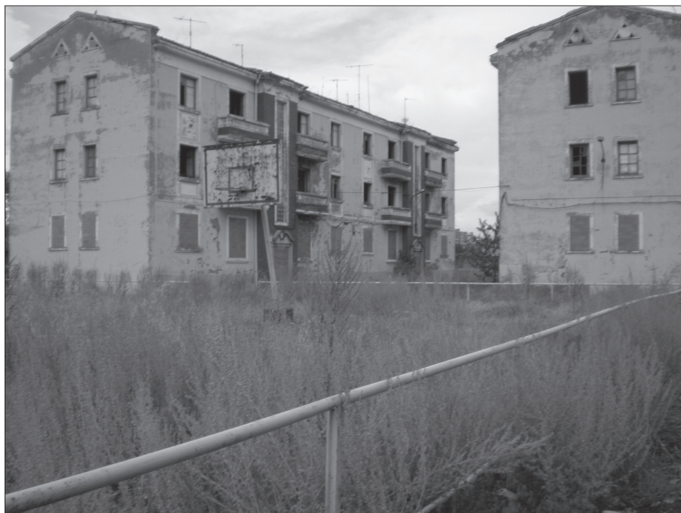
6. BLOQUES ABANDONADOS DE LA AZUCARERA DE LEÓN.
