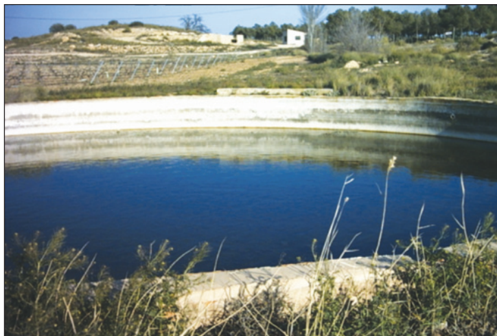
Fotografía nº 4 DEPÓSITO DE AGUA AL AIRE LIBRE PARA RIEGO. «PARAJE LA COLORÁ»
