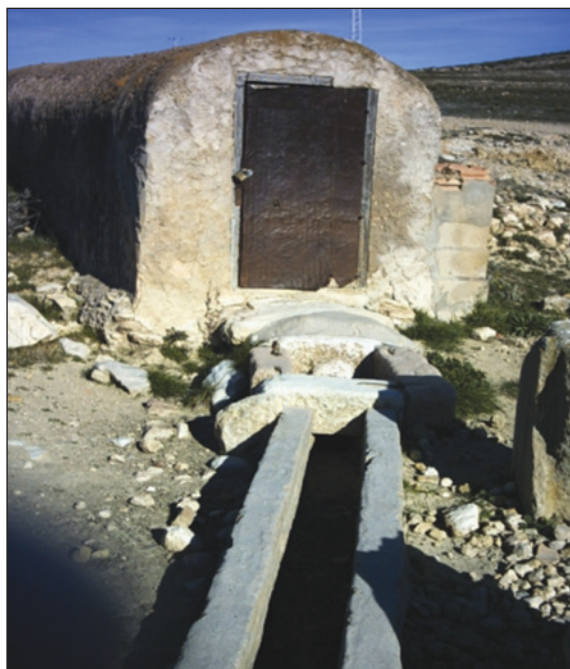
Foto 3 CANALIZACIONES SITUADAS EN EL PARAJE DEL «PULPILLO»
