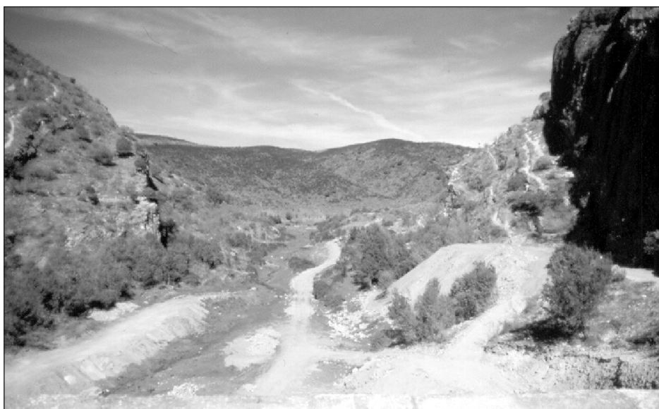
Figura 1. Vista de la presa del Pontón de la Oliva, en el Lozoya y vaso vacío y abandonado de la misma. Sicre propuso levantar su presa en la confluencia de dicho río con el Jarama, en el estrecho de Guesa, pero admitiendo otra posibilidad: «en Lozoya, a 2.500 varas al NNE de su unión con Jarama, cerrando un estrecho que llaman el Pontón de la Oliva [vista superior], para recogerlas en una concha que forman los montes [vista inferior]». Esa fue, precisamente, la solución que, años después, adoptaron Rafo y Ribera, dando origen al Canal de Isabel II, al que corresponden estas vistas.
