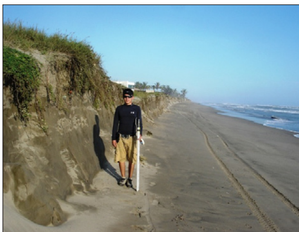
Figura 12 TALUD TRANSVERSAL DE LA CADENA DE DUNAS - ESTACIÓN 6
