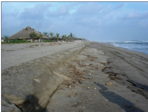
Figura 13 PERFIL DE LA ESTACIÓN 7, CON ASENTAMIENTOS RÚSTICOS
