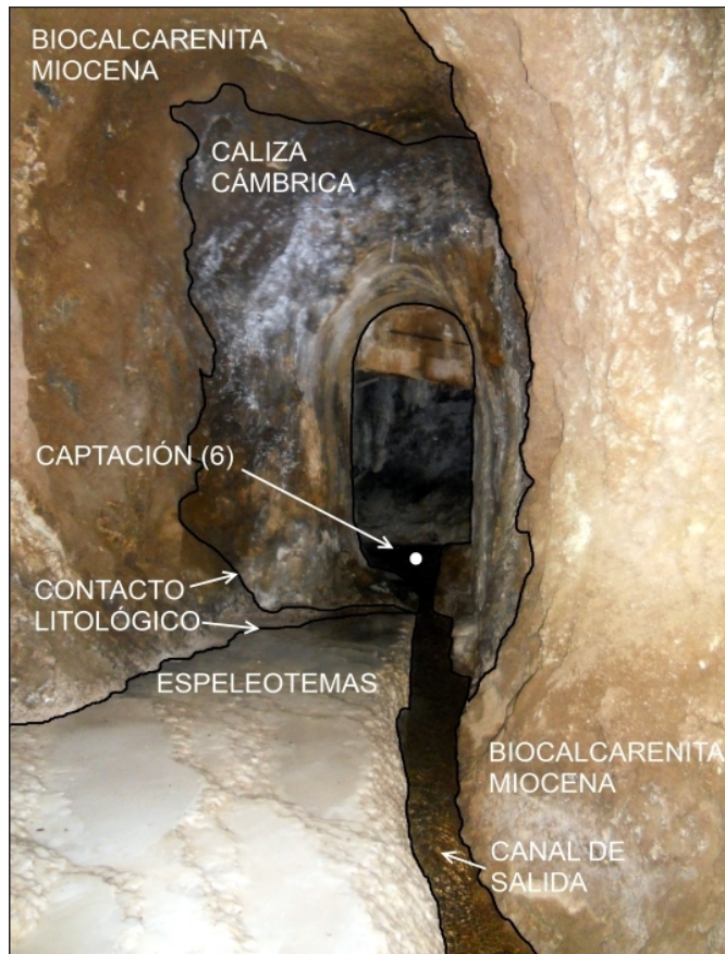
Figura 8 ELEMENTOS LITOLÓGICOS Y MORFOLÓGICOS DE LA MINA DE HUERTAS UNIDAS
