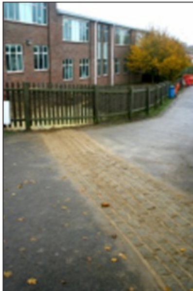
Figura 7 ELEMENTO PARA INTERCEPTAR Y DESVIAR LA ESCORRENTÍA
