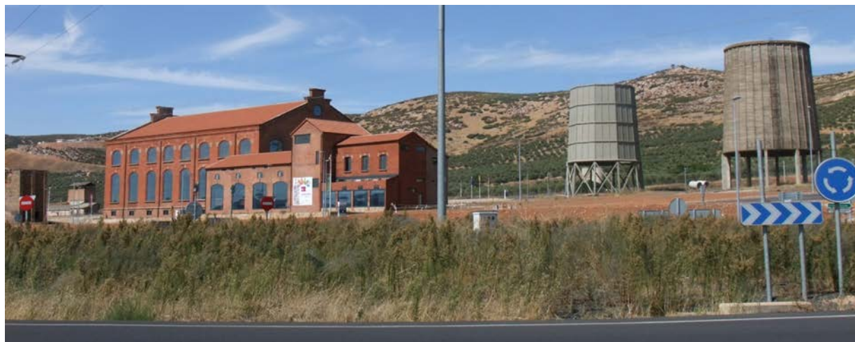
Figuras 20. La Central de Puertollano
