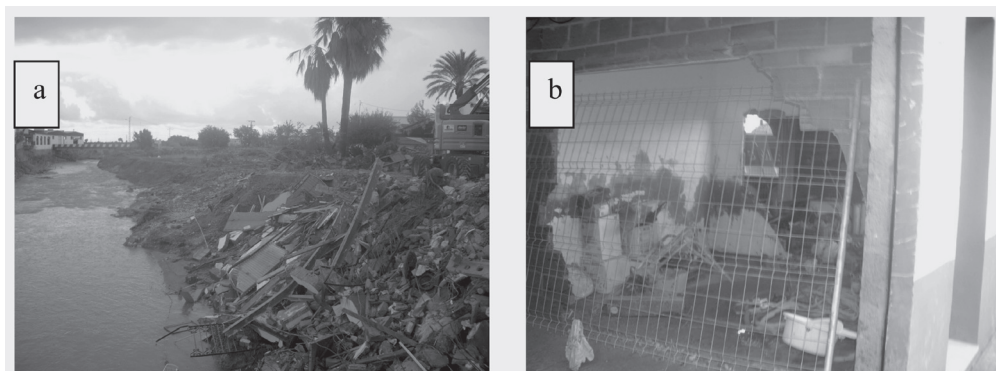
Figura 13 A) CASA DE EL VERGER DERRUMBADA POR LAS AGUAS Y SITUADA EN EL MARGEN DERECHO, B) AGUJERO ABIERTO POR EL AGUA EN EL INTERIOR DE UNA VIVIENDA EN LA MISMA ORILLA
